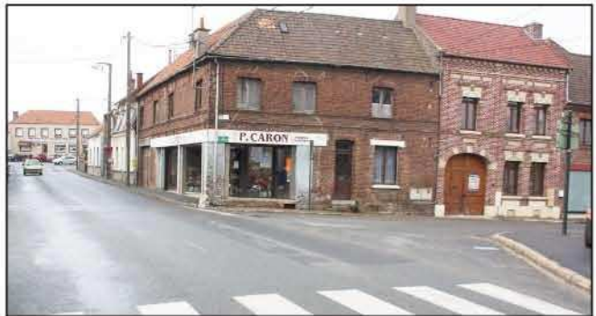
Les travaux débiteront à partir de l'intersection avec la Grand'rue...
